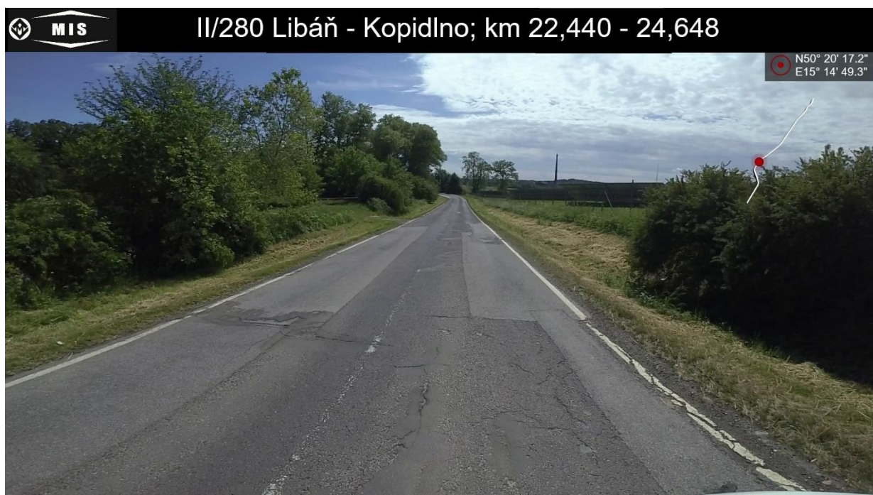
12 Trhliny příčné úzké
