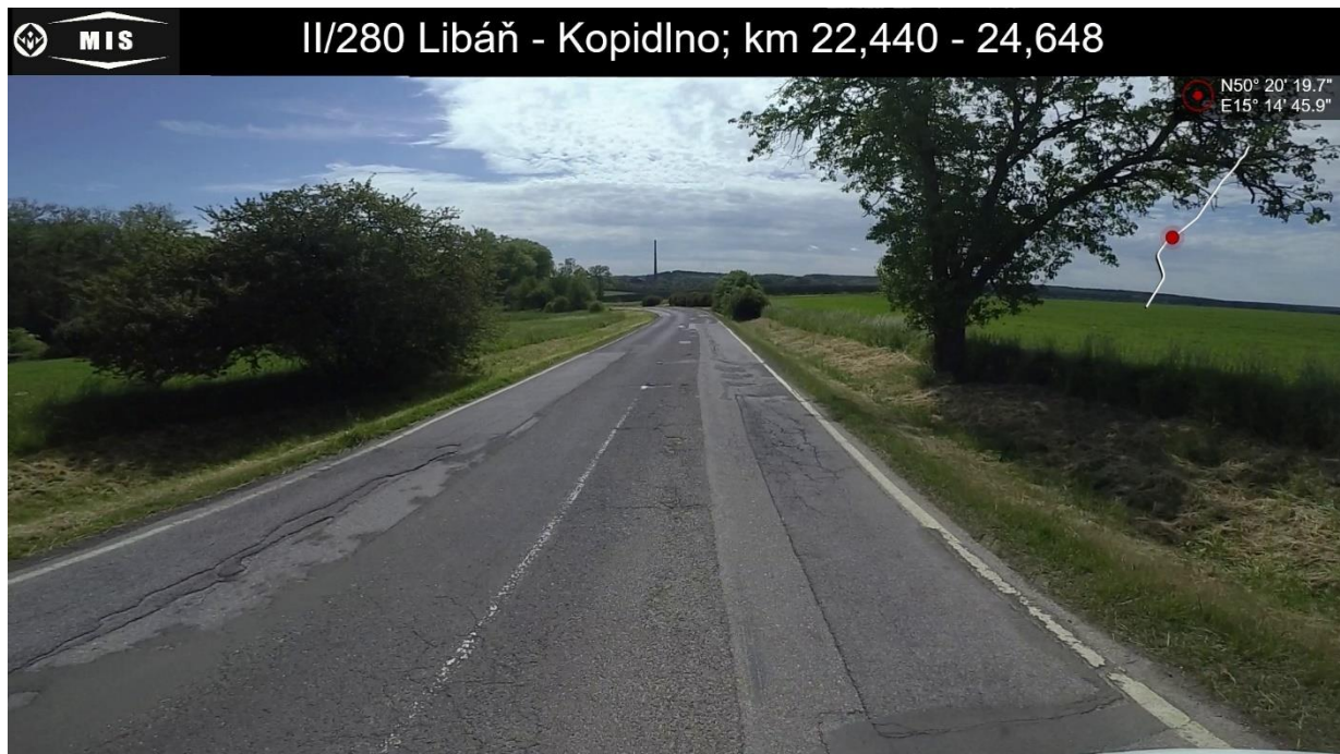
11 Trhliny úzké podélné
