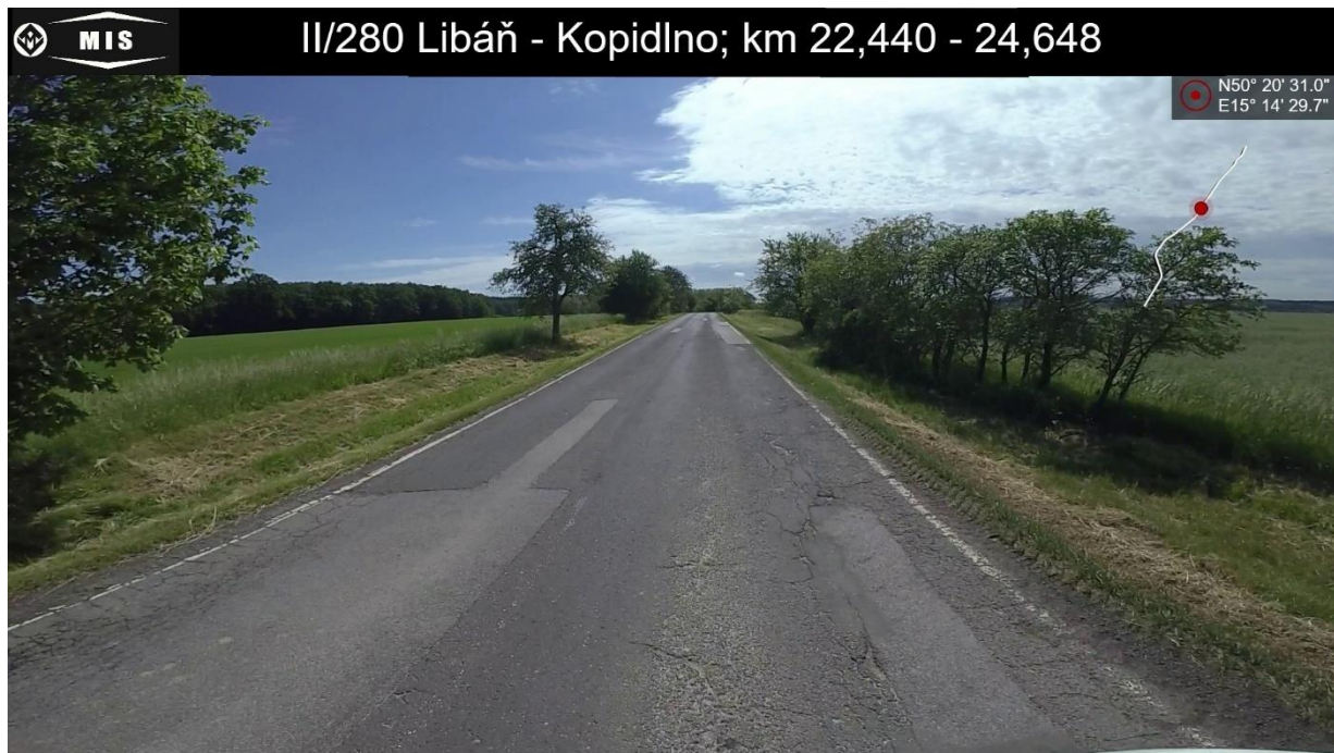
17 Síťové trhliny
