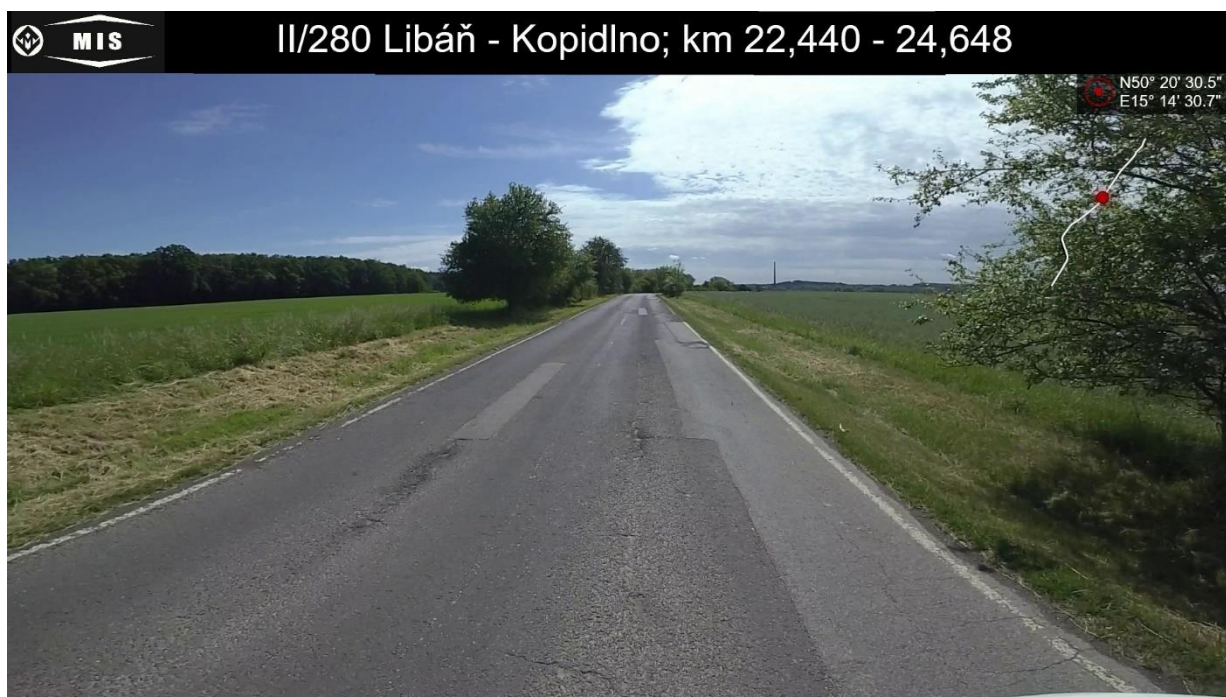
08 Výtluky v ohrusné vrstvě a krytu
