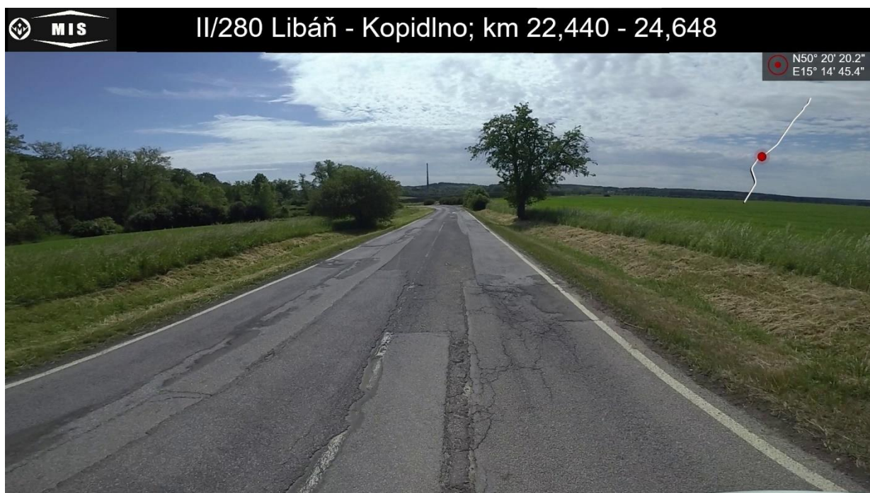
15 Trhliny podélné rozvětvené
