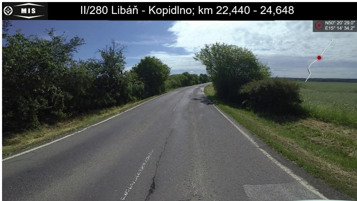
13 Trhliny podélné široké
